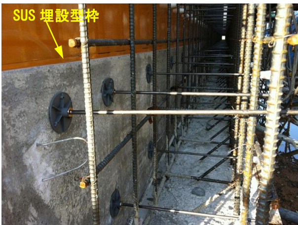
写真-9 SUS埋設型枠の組立状況
