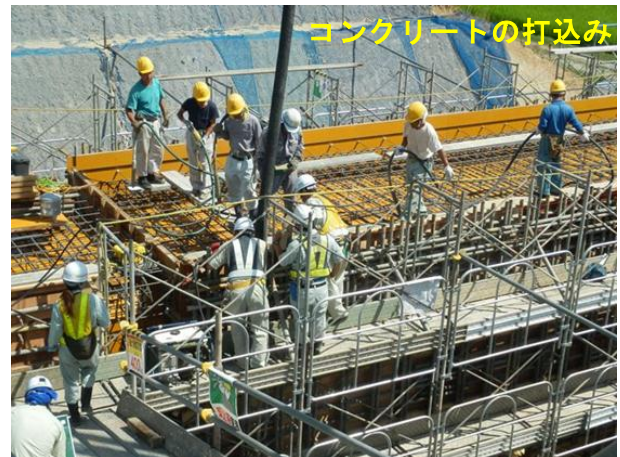
写真-10 函渠工の施工状況
