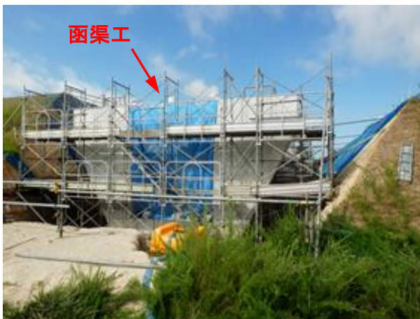
写真-11 函渠工の外観
