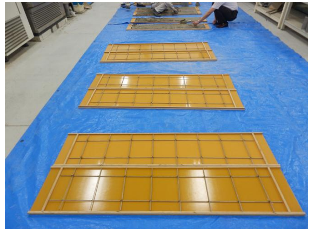
写真-6 SUS埋設型枠の製作状況
