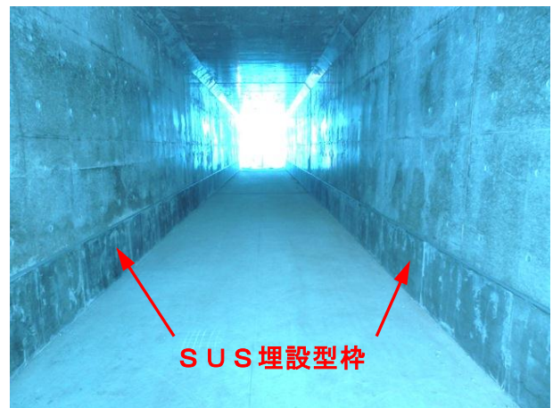
写真-12 函渠工の内面
