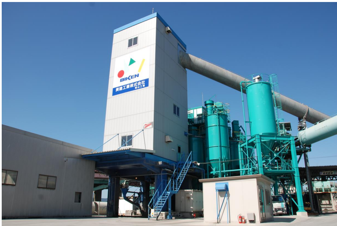
バッチャープラント（福山工場）
