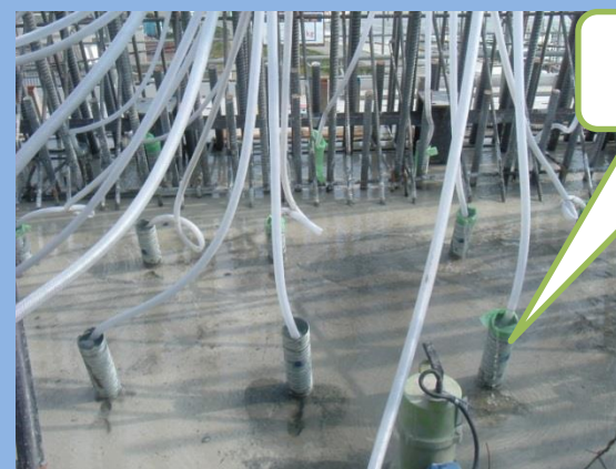
鉛直パイプクーリングと溢れた水で養生
