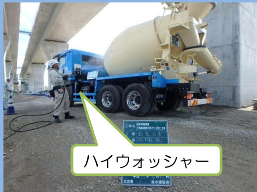
暑中温度対策(ドラム散水)
