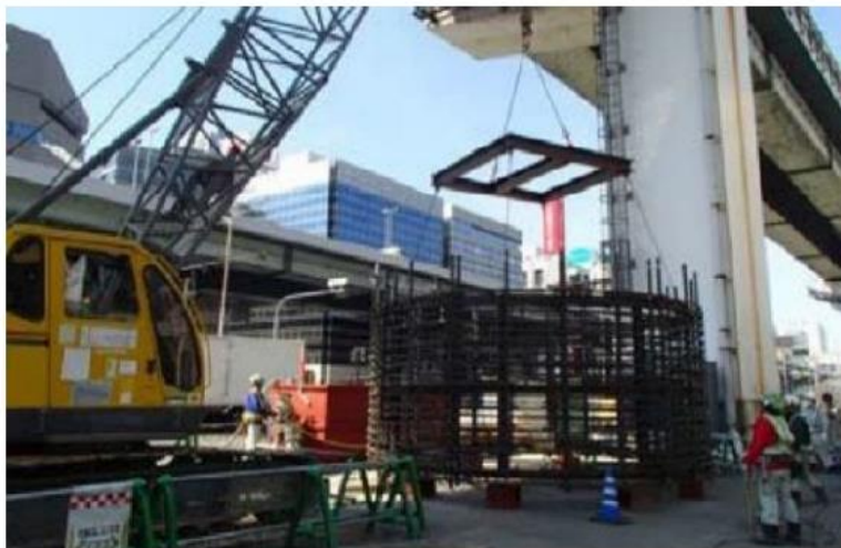
写真-解 3.4.1 ケーソン基礎への適用事例
