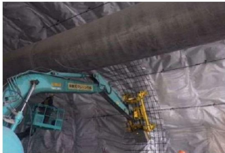
写真-解 3.4.2 トンネル覆工への適用事例
