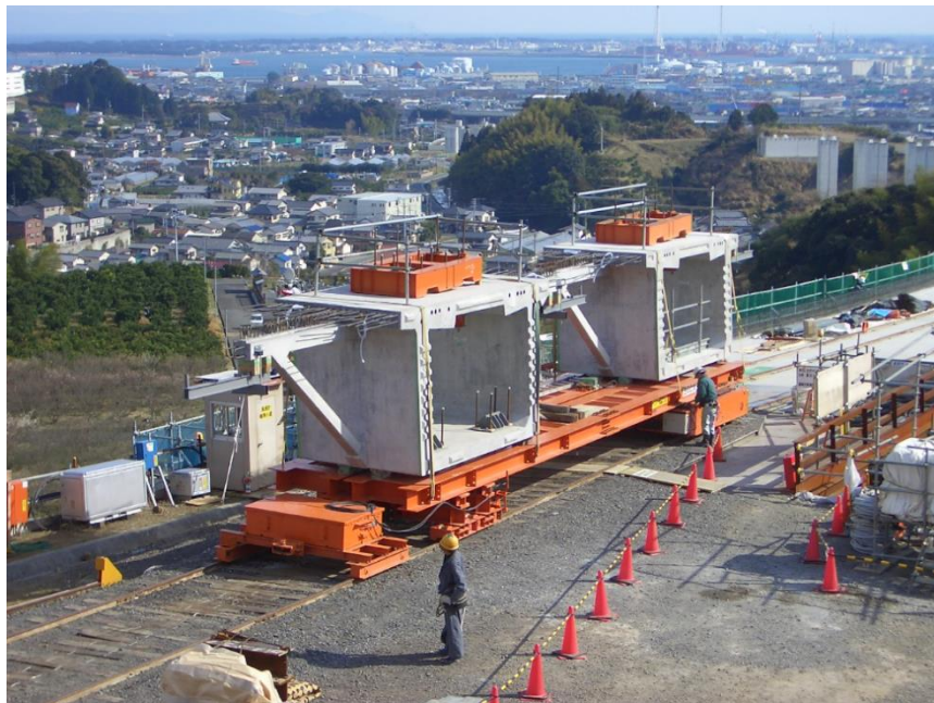
セグメント運搬状況
