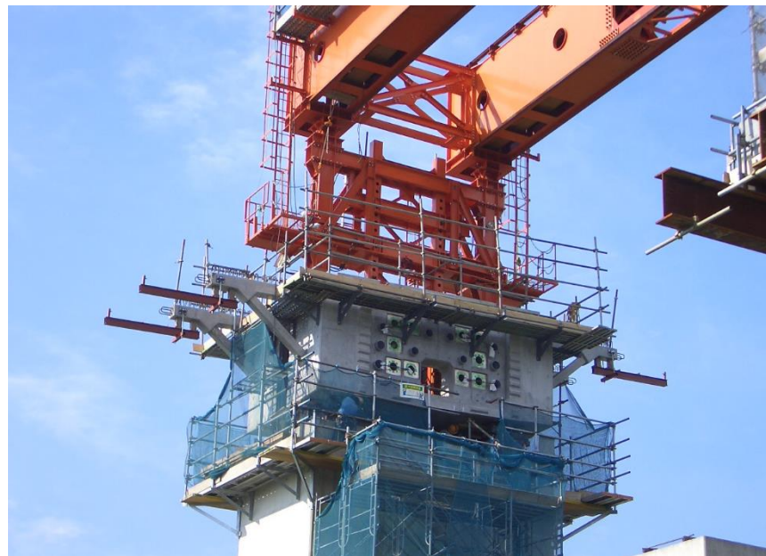
柱頭部セグメント架設完了
