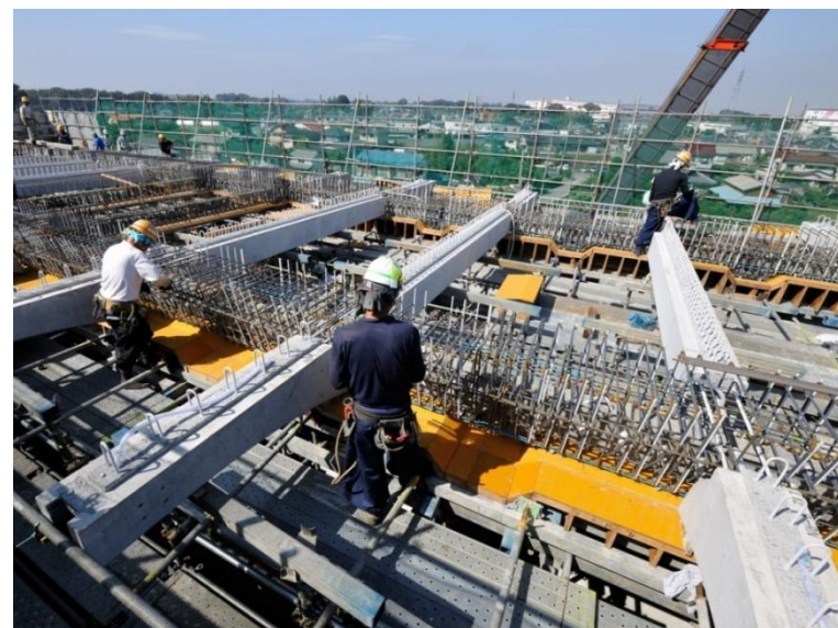
プレキャストリブ架設状況
