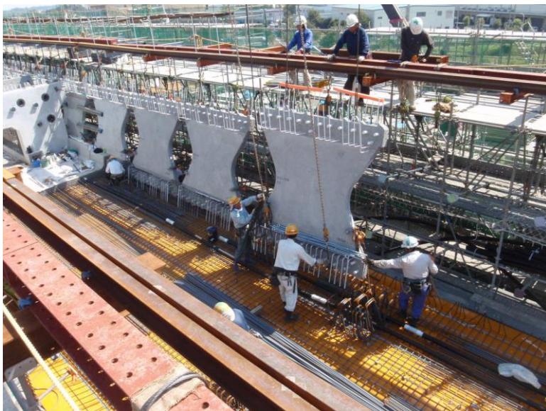
バタフライウェブ架設状況
