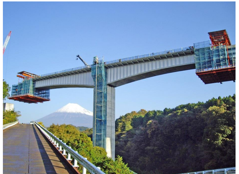
張出し架設状況
