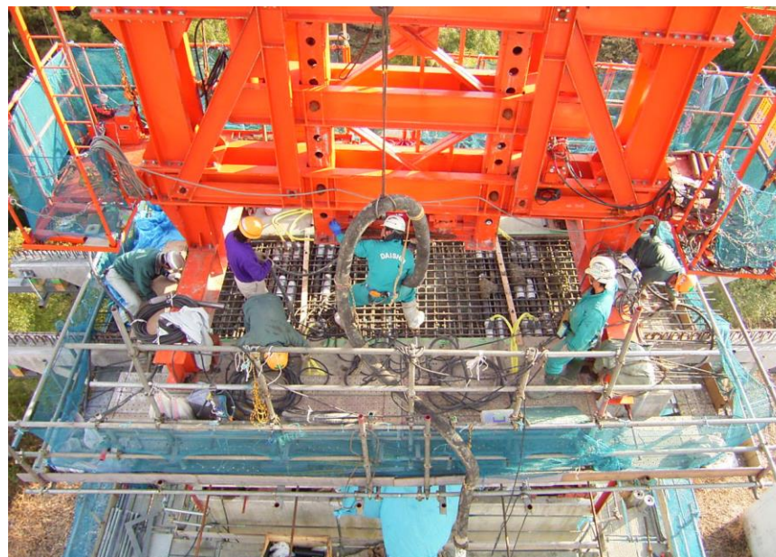
中詰コンクリート打設状況
