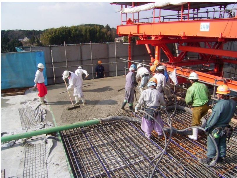
床版コンクリート打設状況
