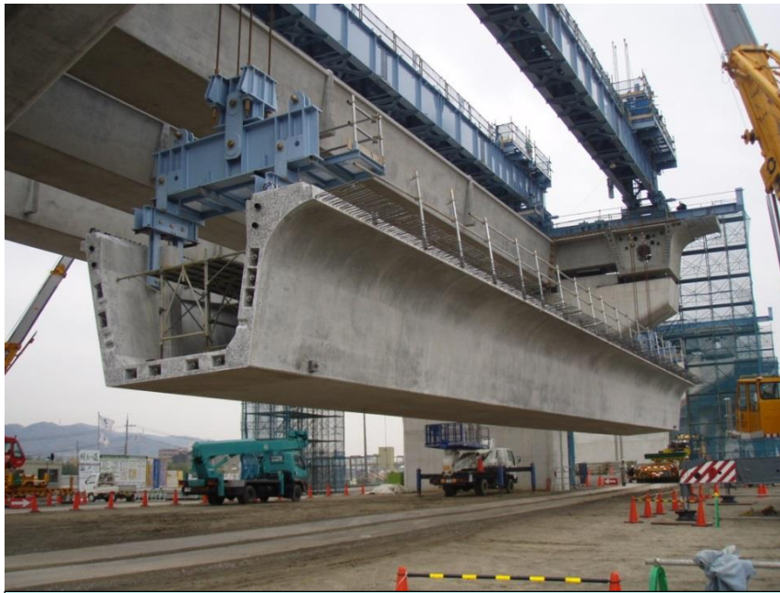
プレキャストU桁架設状況
