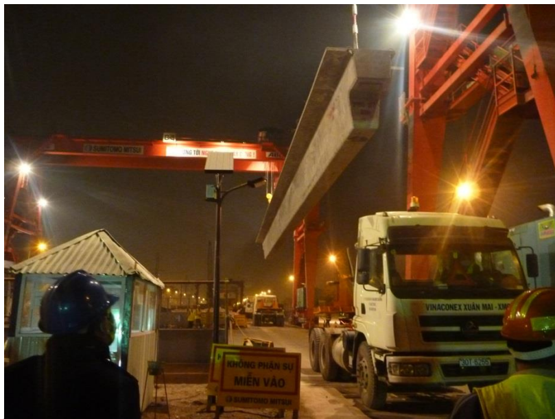
スーパーT桁架設状況
