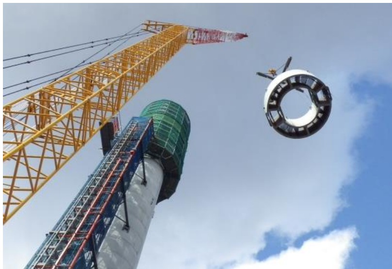
セグメント架設状況
