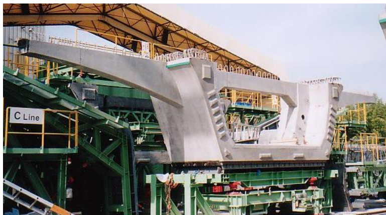
リブ付きU形コアセグメント 【新名神高速道路 古川高架橋】
