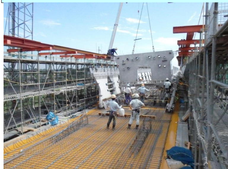
プレキャスト隔壁架設状況
