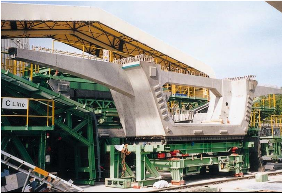
セグメント製作状況
