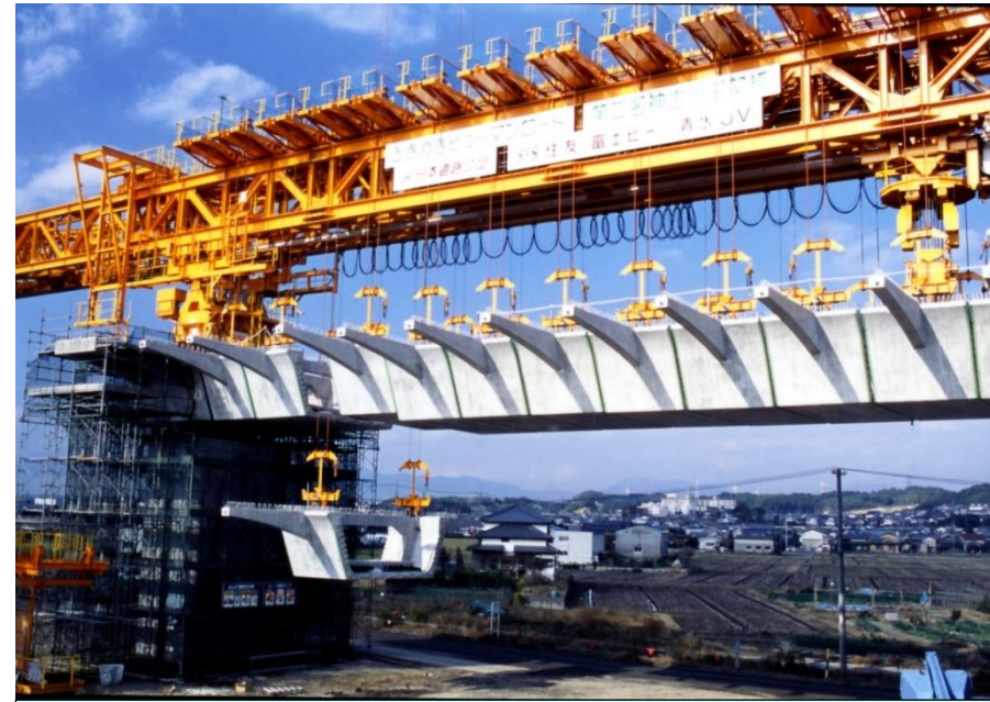
セグメント架設状況
