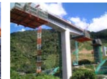
波形ウェブ橋合理化施工
