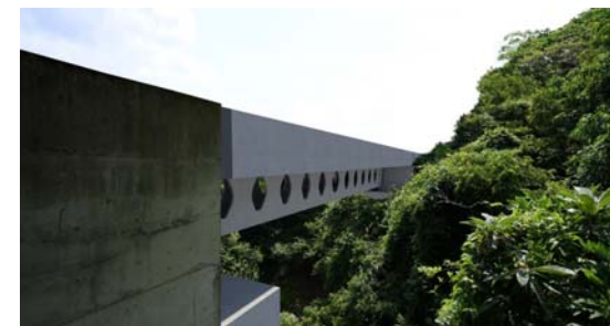
写真提供：西日本高速道路株式会社
