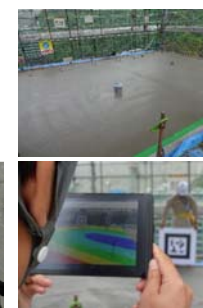
ARによる均し面測量
