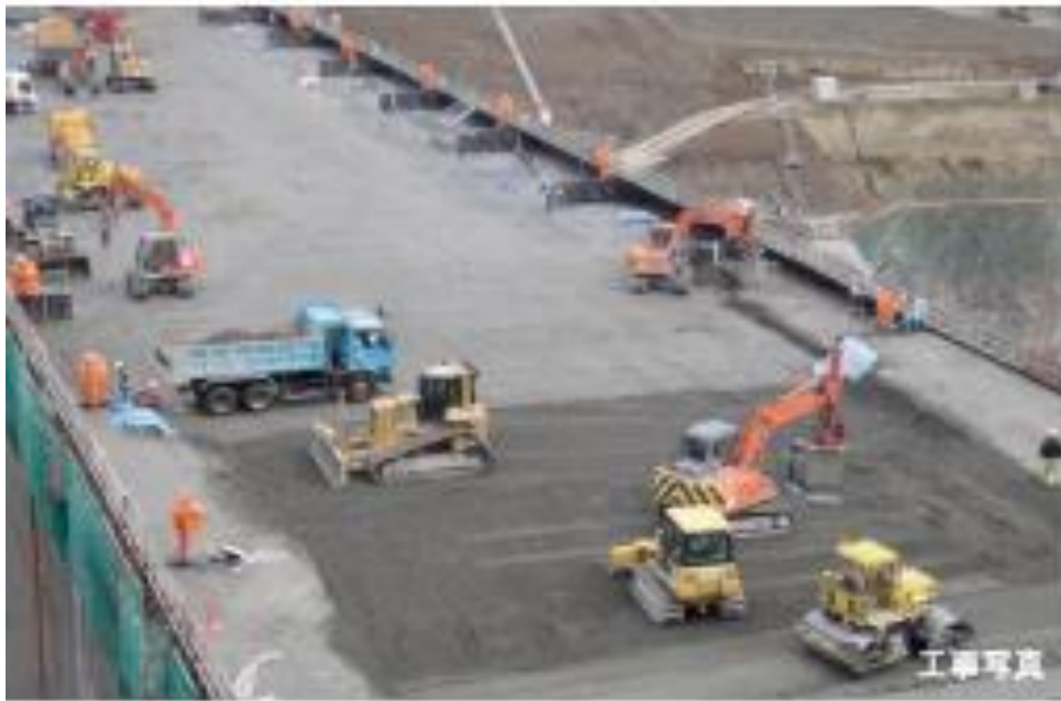
ダムの機械化施工
