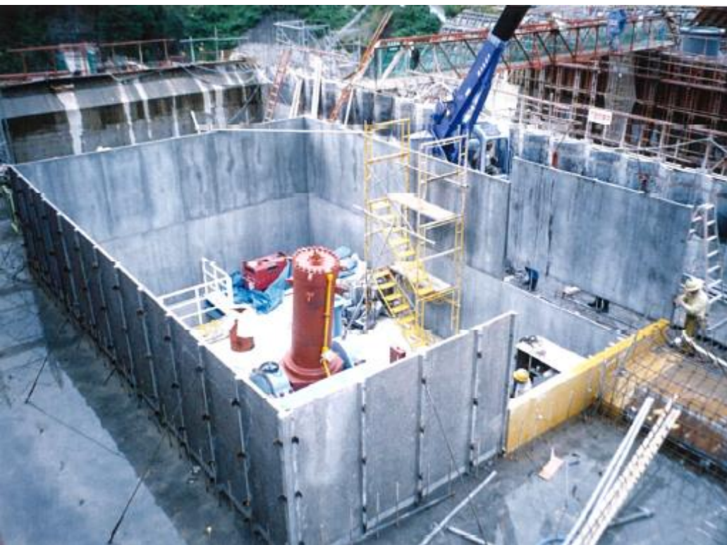
ダムゲート室
