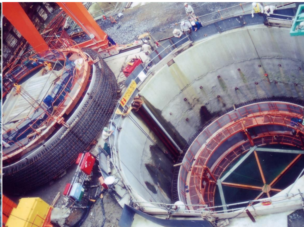
原子力発電所立坑
