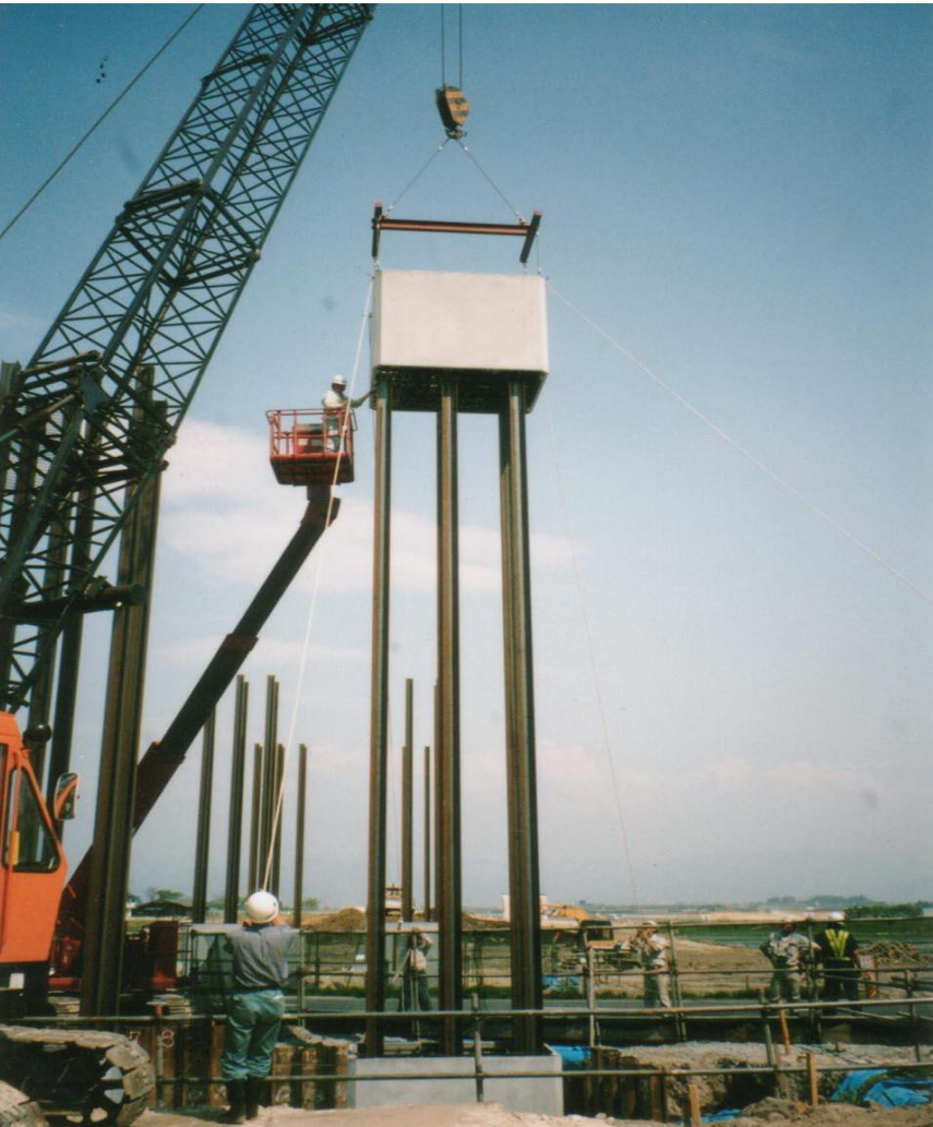
函体建込状況
